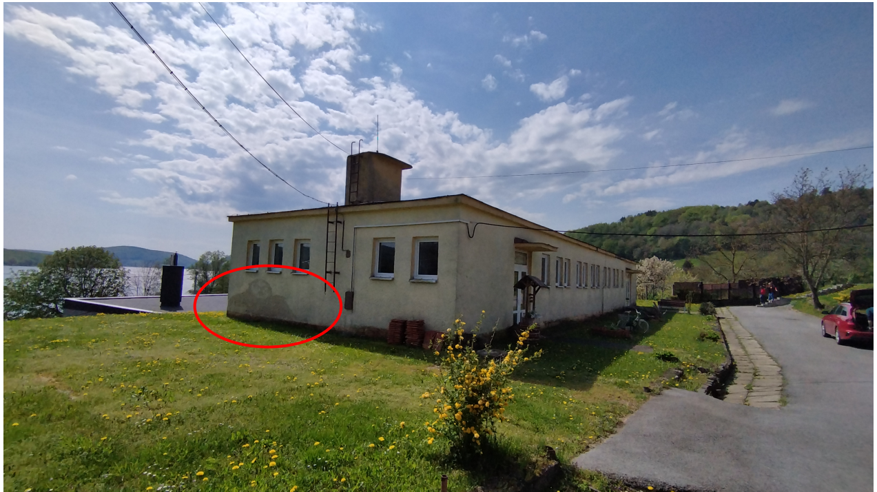
Obr. 5 Severný pohľad na objekt
