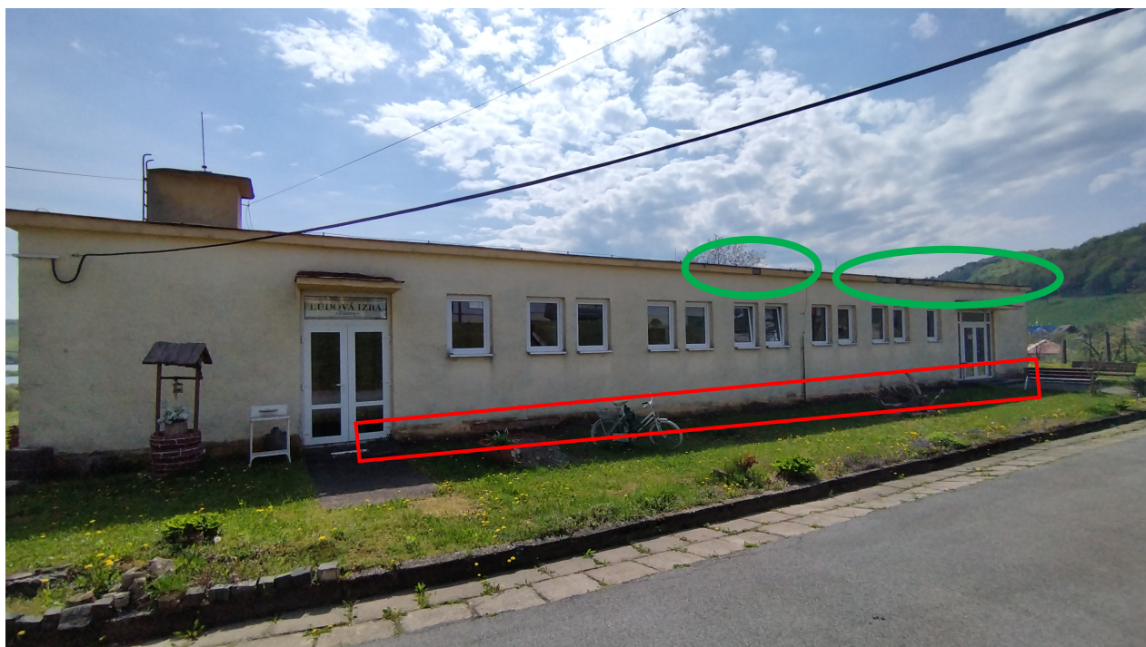
Obr. 4 Severozápadný pohľad na stavebný objekt – je vidieť obidva vstupy do objektu, taktiež železobetónové konzoly nad vstupmi.
