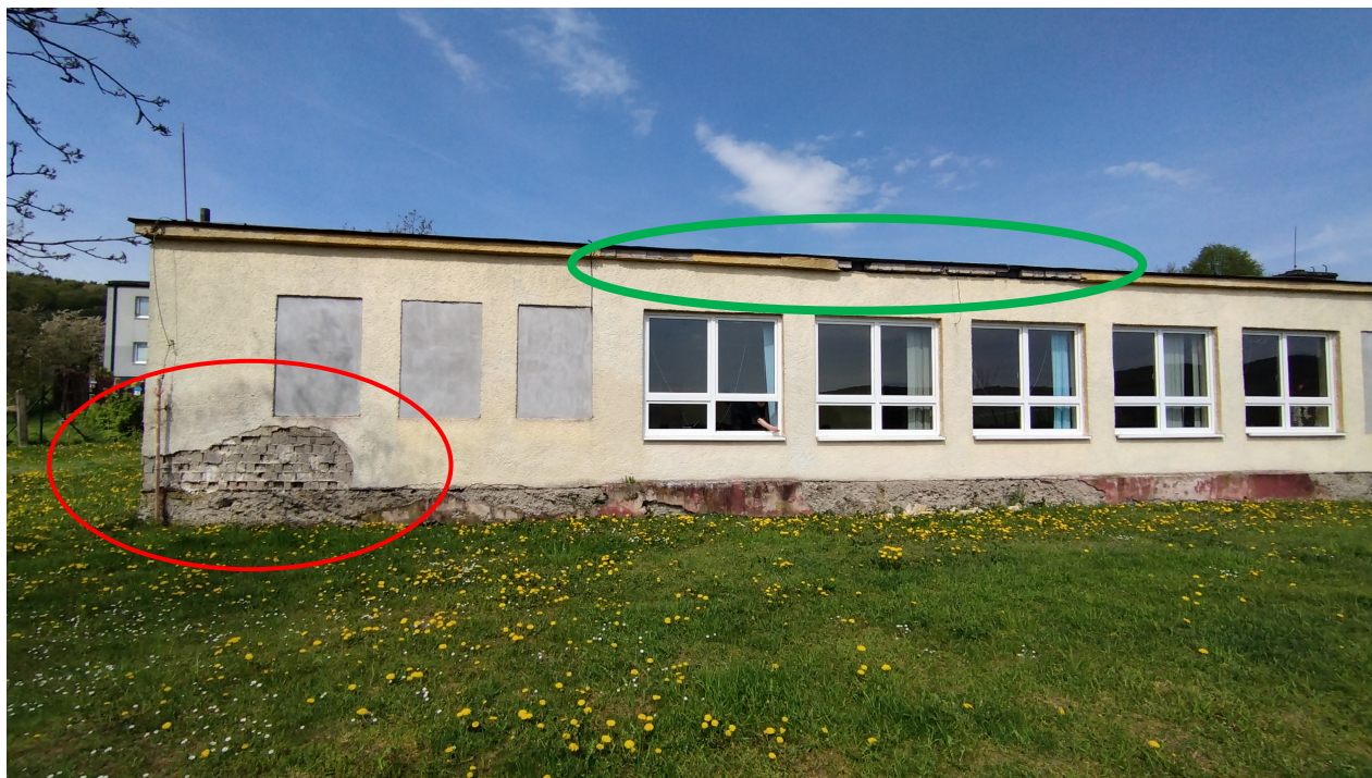
Obr. 9 Juhovýchodný pohľad na objekt
