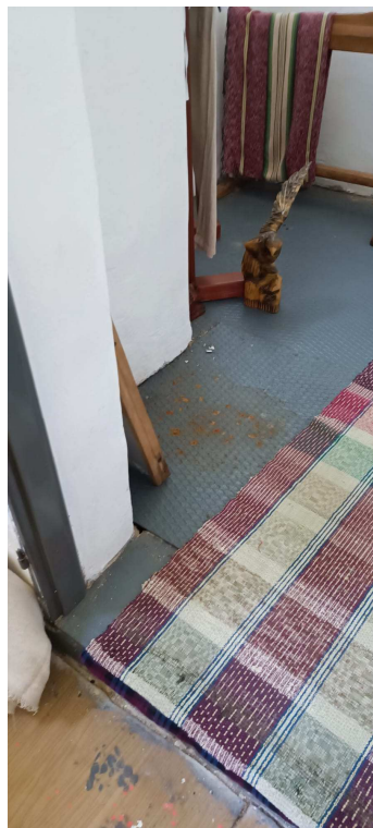
Obr. 20 Pohľad na oceľovú pochôdznu podlahu v miestostiach označených 1.18 (IZBA) a 1.20 (chodba) podľa ASR časti.
