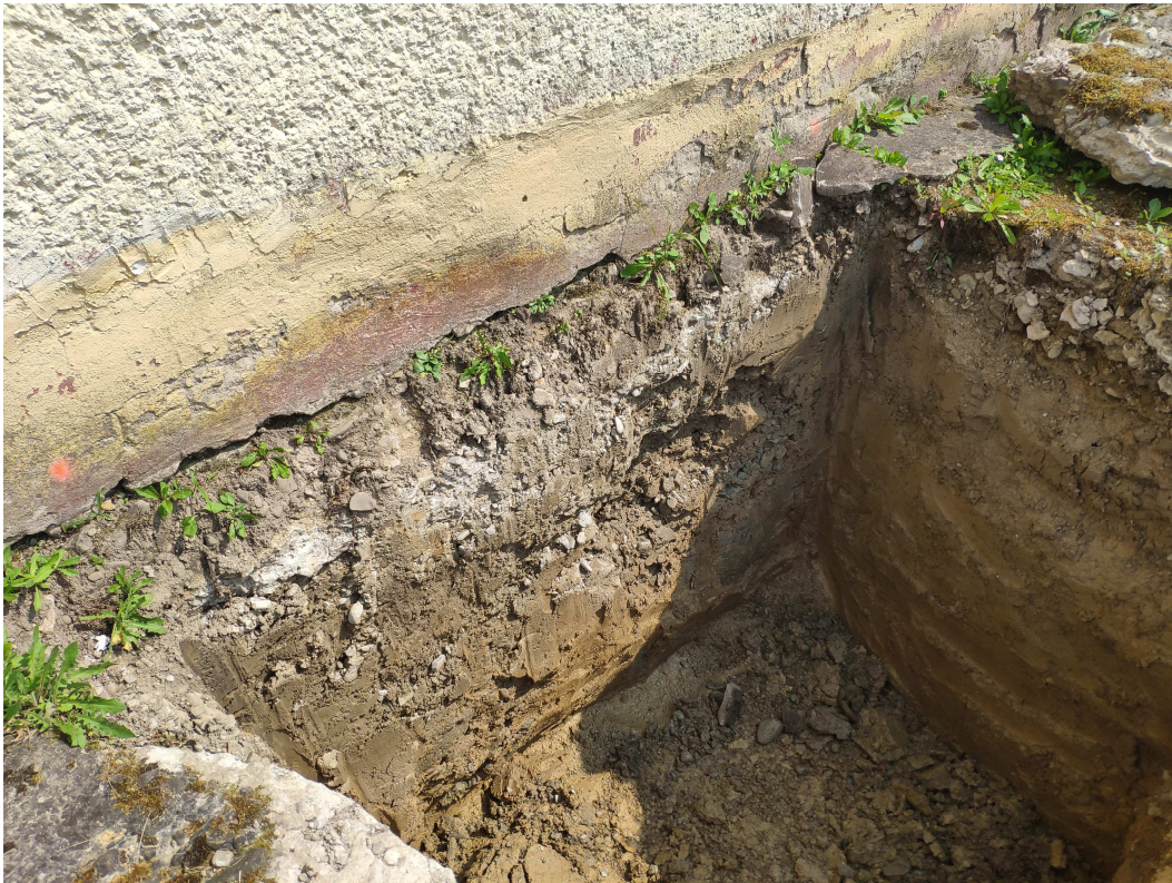
Obr. 21 Kopaná sonda na Severozápadnej strane objektu, medzi vstupmi do budovy. Hĺbka výkopu 1,20 m pod existujúcim terénom. Základová škára maximálne 1,10 m pod upraveným terénom.
