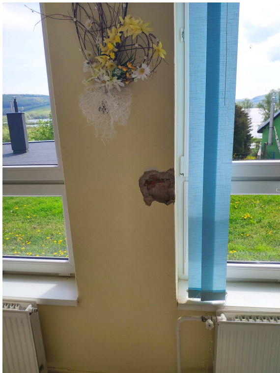
Obr. 25 Vľavo: sonda do medziokenného piliera v sále objektu. Zistený formát keramických tvárnic CDm. Vpravo: detail tvárnice.
