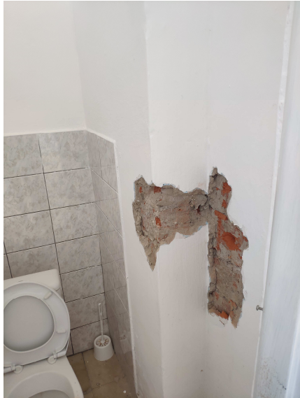
Obr. 24 Vľavo: sonda do murovaného výklenku pri hlavnom vstupe do objektu. Zistený formát keramických tvárnic CDm.
