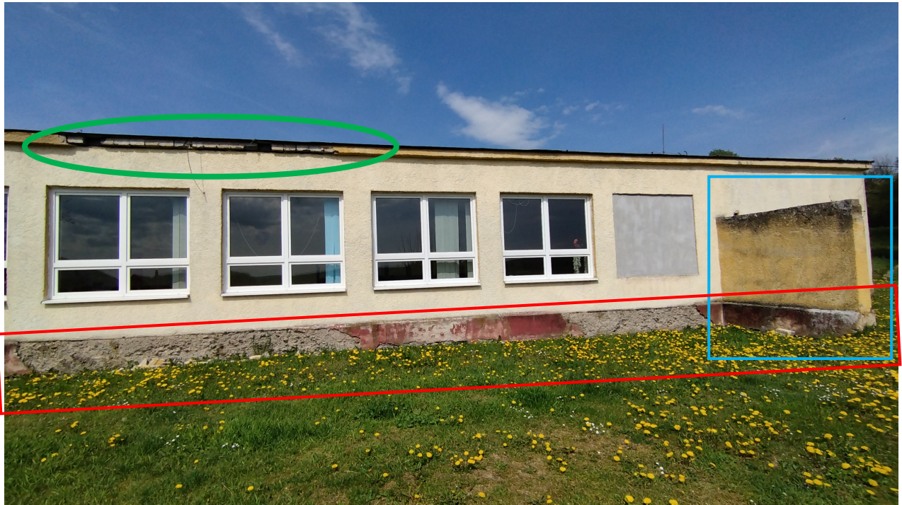
Obr. 7 Juhovýchodný pohľad na objekt
