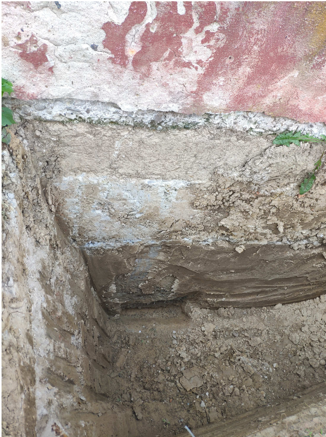
Obr. 23 Kopaná sonda na juhovýchodnej strane objektu, v mieste pod medziokennými piliermi sály. Hĺbka výkopu 1,50 m pod existujúcim terénom. Základová škára maximálne 1,40 m pod upraveným terénom.
