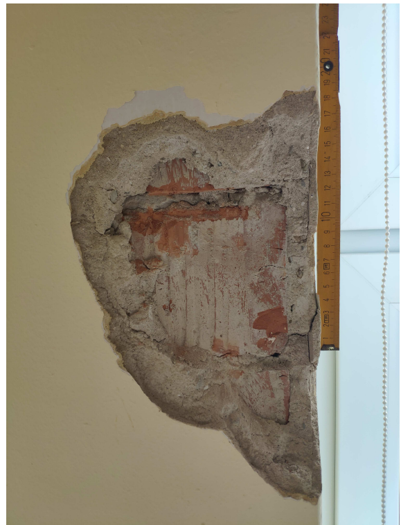
Obr. 25 Vľavo: sonda do medziokenného piliera v sále objektu. Zistený formát keramických tvárnic CDm. Vpravo: detail tvárnice.
