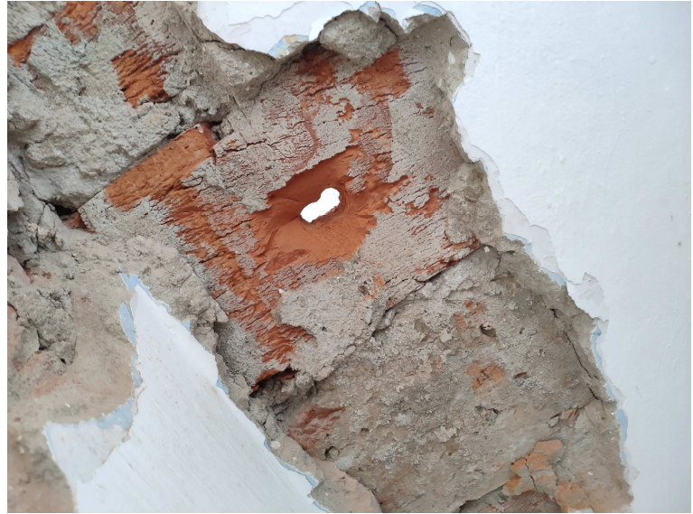
Obr. 24 Vľavo: sonda do murovaného výklenku pri hlavnom vstupe do objektu. Zistený formát keramických tvárnic CDm.
